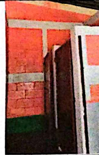
Cambio de ventanales de madera por ventanales de metal
