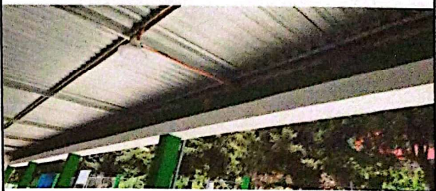
Sustitución de Techo
