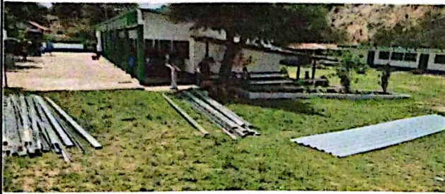
Sustitución de Techo
